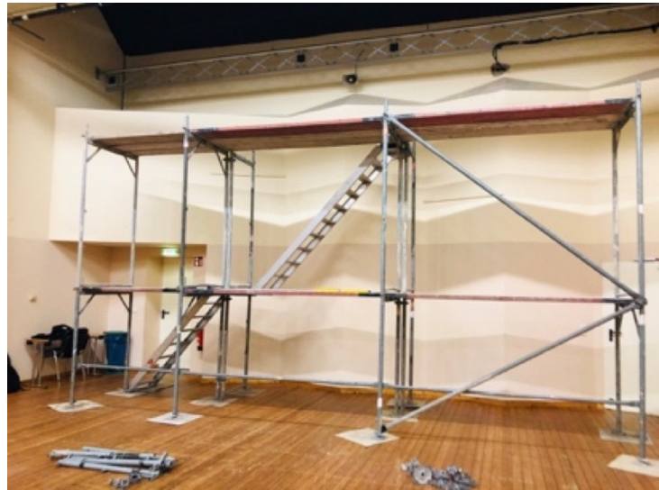
Anlieferung durch Z+O Gerüstbau Brandenburg des Gerüsts & Mitten im Aufbau des 2 stöckigen Gerüsts (Höhe 3,50m)
